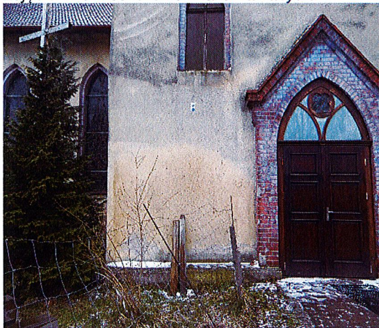
Zdjęcie 1. Umieszczenie znaku na zabytku
