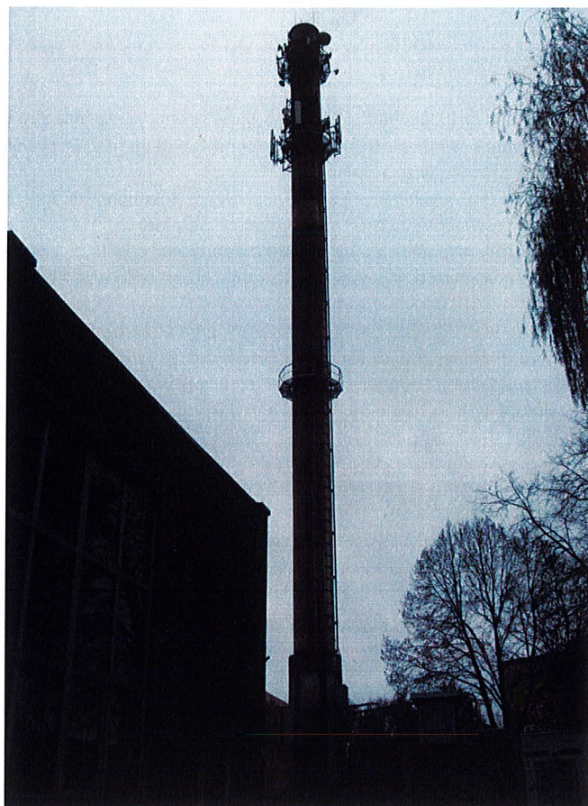
Zał. nr 1: Widok ogólny instalacji radiokomunikacyjnej.
