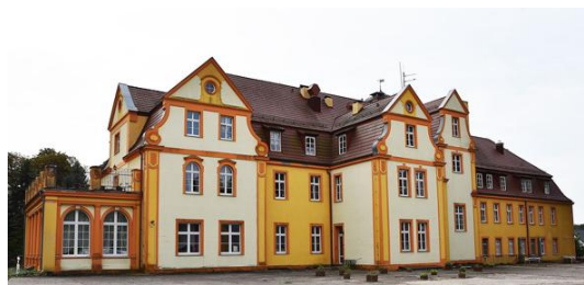
Fotografia 20. Widok na pałac w Brzezinach Źródło: Zbiory Starostwa Powiatowego w Choszczynie
