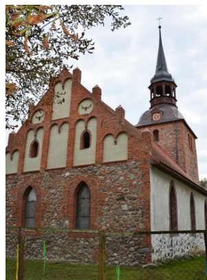
Fotografia 7. Widok na Kościół filialny pw. św. Stanisława Kostki w Korytowie Źródło: Zbiory Starostwa Powiatowego w Choszcznie
