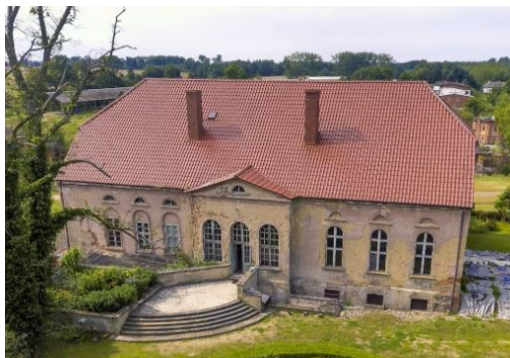
Fotografia 22. Widok na pałac w Przybysławiu Źródło: Zbiory Starostwa Powiatowego w Choszczynie
