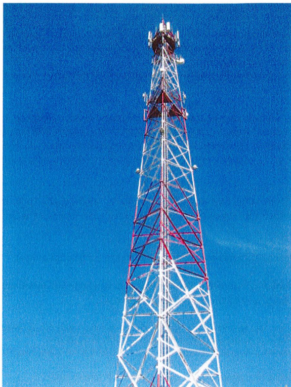
Zał. nr 1: Widok ogólny instalacji radiokomunikacyjnej.
